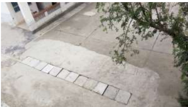
县人民医院医疗区 2#化粪池
