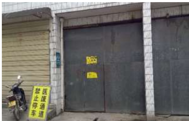
医疗固废储存间及标识
